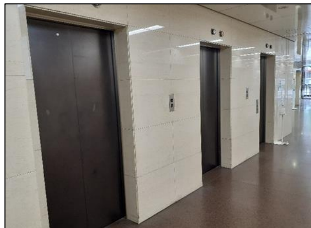
【Before】エレベーターホール
