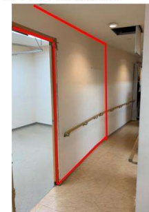
① 入り口ハビリ室の壁(レントゲン室との境界の壁まで)と②壁面据付ソファの撤去 ※ ブラインドは撤去しない。
