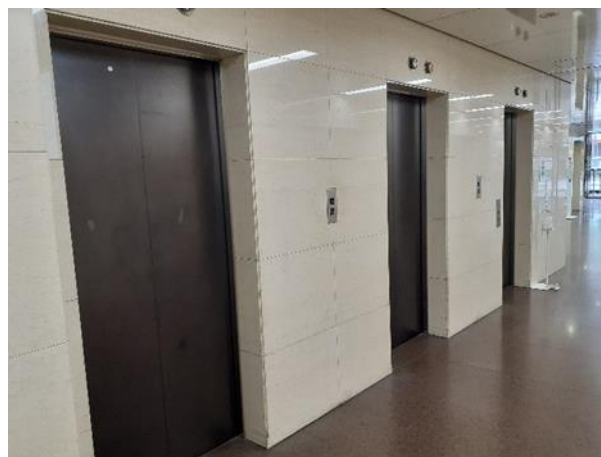
【Before】エレベーターホール
