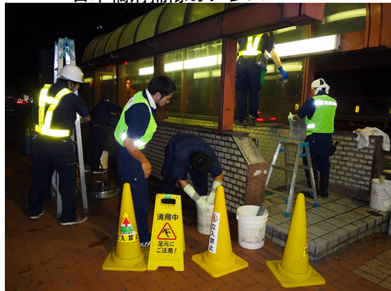
地下道の高圧洗浄の様子
